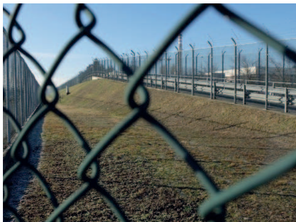
Foto 13 e 14 - il rilevato esistente con le sponde inerbite (analoghe a quanto sarà realizzato sul nuovo argine in progetto)
